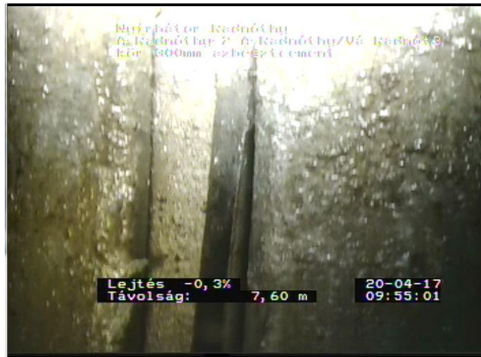
Gumigyűrű elcsúszás az illesztésnél.
