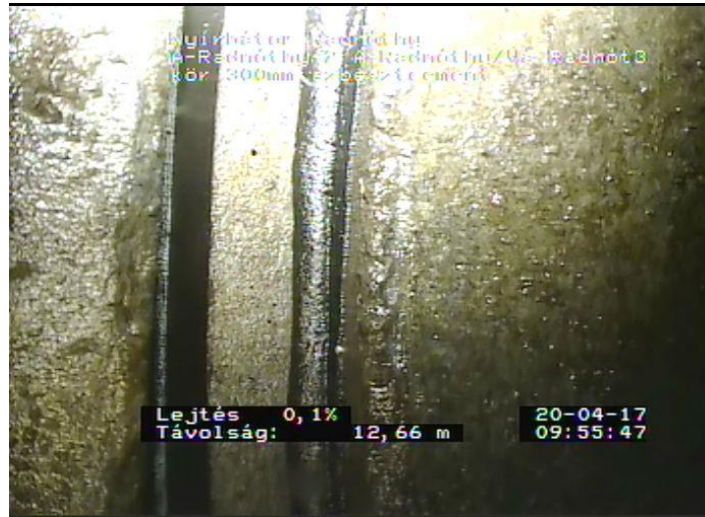
Gumigyűrű elcsúszás az illesztésnél.
