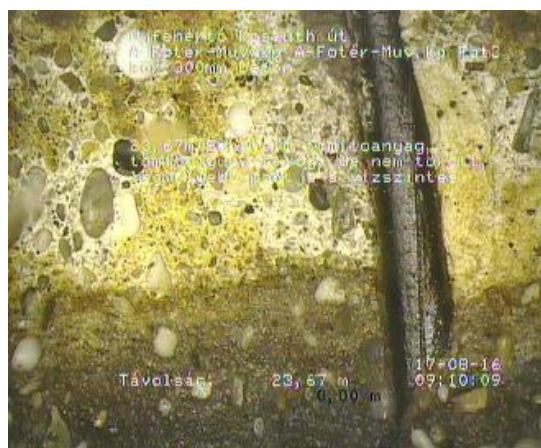
23,67 méternél gumigyűrű belóg, toldás hiányos
