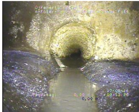
Kikavicsolódás mértéke az aknából
