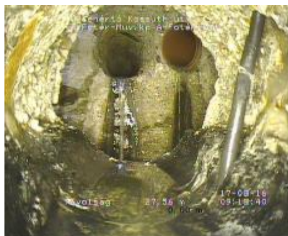
27,6méternél gumigyűrű belóg, toldás repedt -15-
