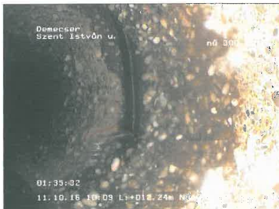
fotó: 4_7a, videoszalag száma: 102, 01:35:32 tömlőgyűrű erősen belóg, től 10 ig 02 óra
