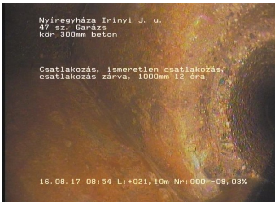
Irinyi 12_d49f4e63-db05-478d-b7c9-b46f0441f6c7_20170816_085518_658.jpg,00:01:58,21.10 Csatlakozás, ismeretlen csatlakozás, csatlakozás zárva, 1000mm 12 óra
