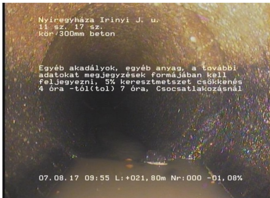
Irinyi3_292f6cad-470c-4395-bb6b-d9a901258f0d_20170807_095544_995.jpg, 00:02:30, 21.80 Egyéb akadályok, egyéb anyag, a további adatokat megjegyzések formájában kell feljegyezni, 5% keresztmetszet csökkenés 4 óra -tól(tol) 7 óra, Csocsatlakozásnál
