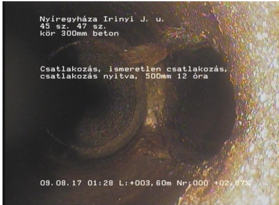
Irinyi 11_582334d5-fdf2-4b60-973c-80bfa3a17c2d_20170809_132826_439.jpg, 00:00:39, 3.60 Csatlakozás, ismeretlen csatlakozás, csatlakozás nyitva, 300mm 12 óra
