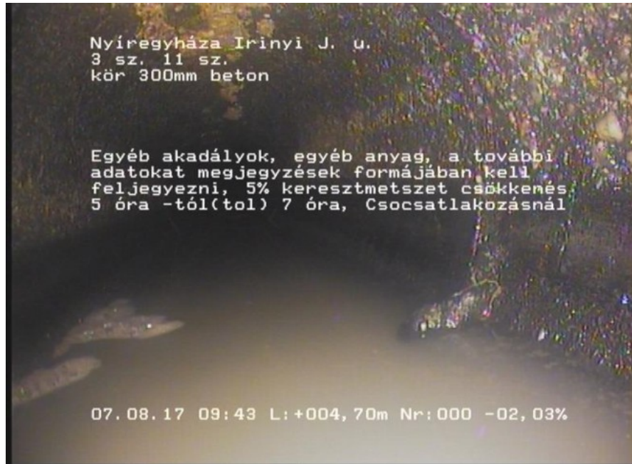
Irinyi2_b3b1057c-96b6-4450-9a92-02effafa9ade_20170807_094355_684.jpg, 00:00:38, 4.70 Egyéb akadályok, egyéb anyag, a további adatokat megjegyzések formájában kell feljegyezni, 5% keresztmetszet csökkenés 5 óra -tól(tol) 7 óra, Csocsatlakozásnál
