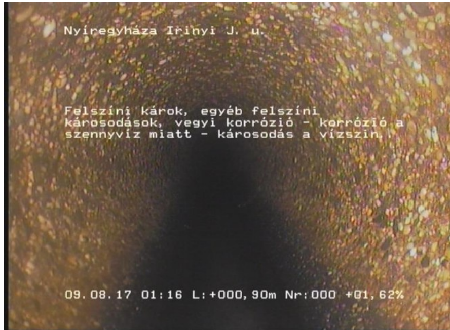
Irinyi10_0b85c278-2985-4f1a-9b1e-12eeb9647de3_20170809_131655_042.jpg, 00:00:08, 0.90 Felszíni károk, egyéb felszíni károsodások, vegyi korrózió - korrózió a szennyvíz miatt - károsodás a vízszin..
