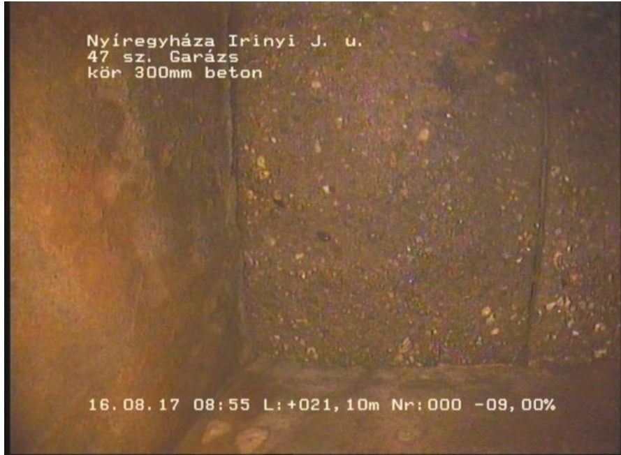
Irinyi 12_321b61ad-deb9-44a7-8323-d77613ee8139_20170816_085528_721.jpg, 00:01:58, 21.10 Csatlakozás, ismeretlen csatlakozás, csatlakozás zárva, 1000mm 12 óra
