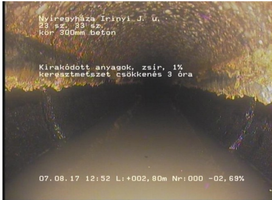
Irinyi5_42d0b9d3-e6ff-47db-8103-2124a2000e2d_20170807_125158_342.jpg,00:00:24,2.80 Kirakódott anyagok, zsír, 1% keresztmetszet csökkenés 3 óra
