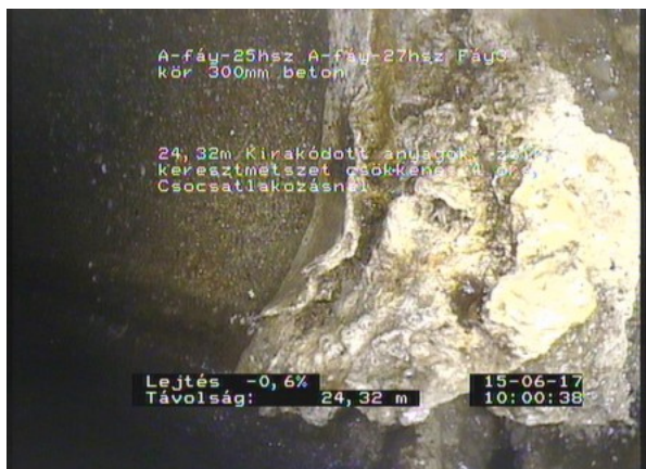
Fáy3_dbe653b8-447d-468b-8038-92d036f9add2_20170615_100212_130.jpg, 00:05:03, 24.32 Kirákodott anyagok, zsír, 5% keresztmetszet csökkenés 4
