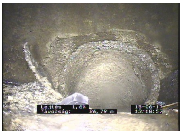
Fáy7_91b454aa-e962-4981-b6d2-1aef8c076697_20170615_132032_339.jpg, 00:08:24, 26.79 Csatlakozás, elágazás - cso egység előre gyártott
