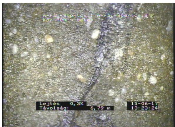
Fáy8_ccd46b2b-127a-4742-b10a-68ebc1c3e86e_20170615_132458_896.jpg, 00:01:59, 6.79 Repedésképződés, felszíni repedés (hajszálrepedés),
