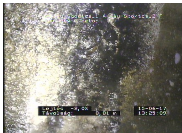
Fáy8_5f66e25f-51c5-4312-bb4b-f8409b5b005c_20170615_132644_497.jpg, 00:03:22, 8.81 Repedésképződés, a törésvonalak felismerhetők a csufalon,
