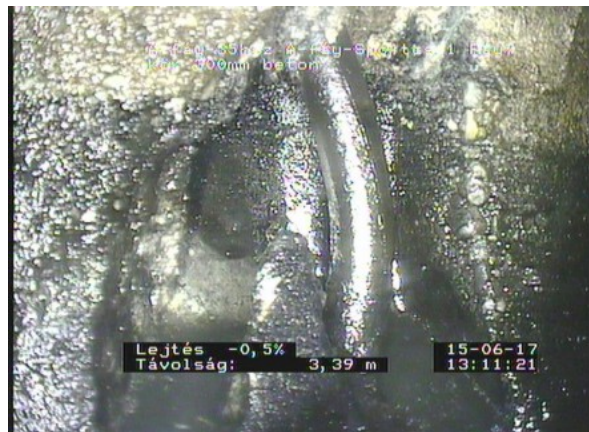
Fáy7_5ba950ef-3432-44b8-96e5-1afa3f0e9b5b_20170615_131256_491.jpg, 00:00:49, 3.39 Elcsúszott kötés, hosszirányban, a csövek a csövezeték
