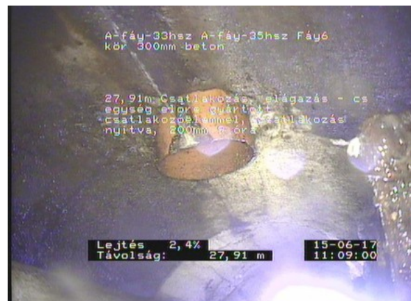
Fáy6_4e9e5df6-895b-48e2-b6fd-bf54730a6783_20170615_1 11034_196.jpg, 00:08:08, 27.91 Csatlakozás, elágazás - cso egység előre gyártott
