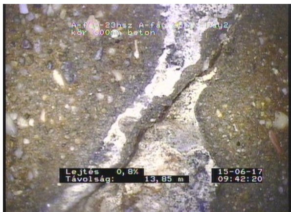
Fáy2_223e1bb4-5395-425f-ae09-93279033f1a9_20170615_094354_569.jpg, 00:04:00, 13.85 Repedésképződés, a törésvonalak felismerhetők a csőfalán,
