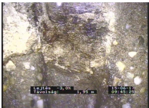
Fáy3_fcda454e-9c62-46cb-a3fe-f658143ef854_20170615_094659_238.jpg, 00:00:37, 1.95 Hibás csatlakozás, a csatlakozócso károsodott 2 óra,
