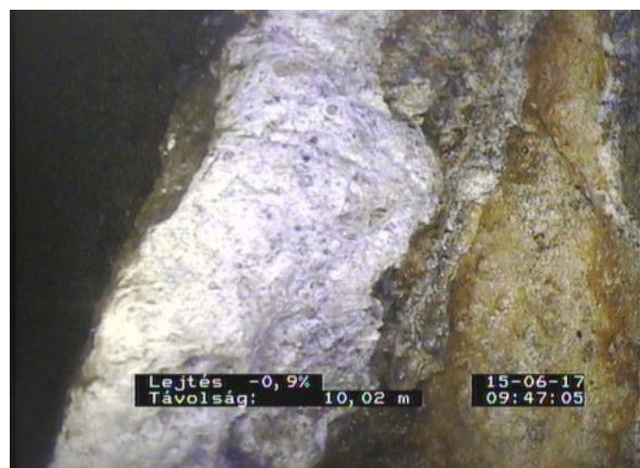
Fáy3_82423ce4-47d0-4acd-82bb-d236211c2341_20170615_094840_070.jpg, 00:02:03, 10.02 Kirákodott anyagok, lerakódás, 10% keresztmetszet
