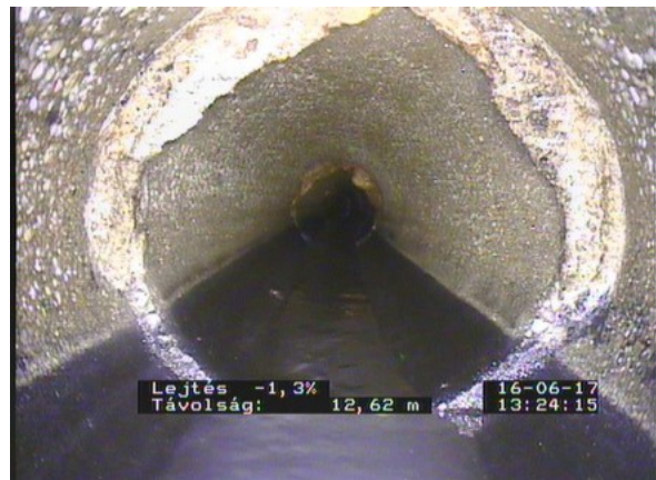
Fáy13_7ab0c9e4-d273-4d6a-b7fe-5269a890682d_20170616_132551_648.jpg, 00:03:28, 12.62 Kirákodott anyagok, zsír, 5% keresztmetszet csökkenés 9 óra
