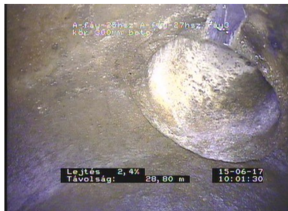
Fáy3_da67dcaa-2862-4098-bf22-dd5c50042ce5_20170615_100304_335.jpg, 00:05:47, 28.80 Csatlakozás, elágazás - cso egység előre gyártott
