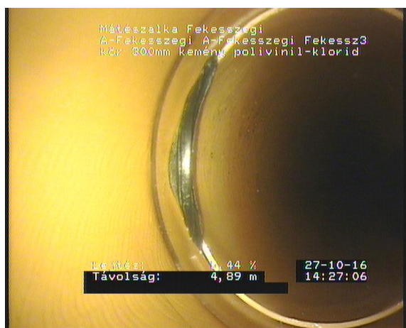
Fekesszegi3_929ce7e8-00ec-44de-8370-b07d751d810a_20161027_142746_685.jpg, 00:01:33, 5.12 Behatóló tömítőanyag, tömítogyuru lelóg, de nem törött, a legmélyebb pontja a vízszintes középvonal felett ..
