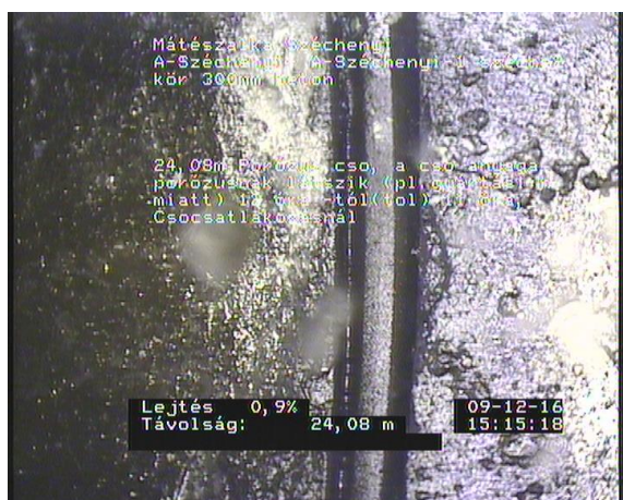
széchenyi2_aaf47d91-fae4-4e9a-8802-79fb2d34895e_20161209_151547_776.jpg, 00:03:34, 24.08 Porózus csó, a csó anyaga porózusnak látszik (pl.gyártási hiba miatt) 12 óra -tól(tol) 11 óra, Csocsatlakozásnál
