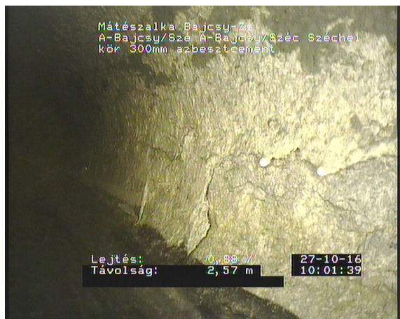
Széchenyi1_d44e8517-fae9-4433-b46c-923a63b12cfe_20161027_100220_507.jpg, 00:00:30, 2.57 Porózus cso, a cso anyaga porózusnak látszik (pl.gyártási hiba miatt) 9 óra -tól(tol) 3 óra
