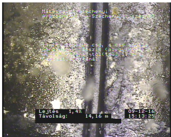
széchenyi2_aaf47d91-fae4-4e9a-8802-79fb2d34895e_20161209_151355_144.jpg, 00:02:13, 14.16 Porózus csó, a csó anyaga porózusnak látszik (pl.gyártási hiba miatt) 12 óra -tól(tol) 11 óra, Csocsatlakozásnál
