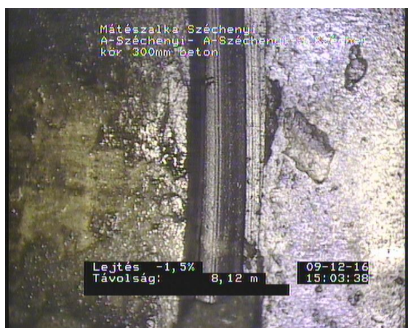
Széchenyi1_734e710d-dc84-4425-9882-9b6b40ed035a_20161209_150408_471.jpg, 00:01:36, 8.12 Porózus csó, a csó anyaga porózusnak látszik (pl.gyártási hiba miatt) 12 óra -tól(tol) 11 óra, Csocsatlakozásnál
