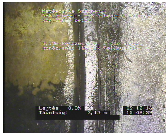
Széchenyi1_734e710d-dc84-4425-9882-9b6b40ed035a_20161209_150308_824.jpg, 00:00:56, 3.13 Porózus csó, a csó anyaga porózusnak látszik (pl.gyártási hiba miatt) 12 óra -tól(tol) 11 óra, Csocsatlakozásnál
