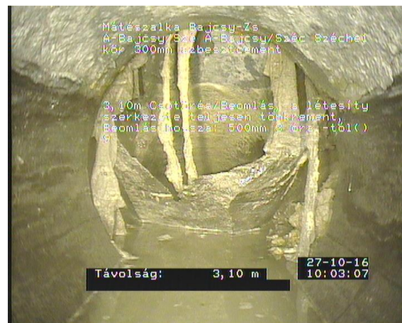
Széchenyi1_d44e8517-fae9-4433-b46c-923a63b12cfe_20161027_100348_090.jpg, 00:01:26, 3.10 Csotörés/Beomlás, a létesítmény szerkezete teljesen tönkrement, Beomlás hossza: 500mm 3 óra -tól(tol) 9 óra, Csocsatlakozásnál
