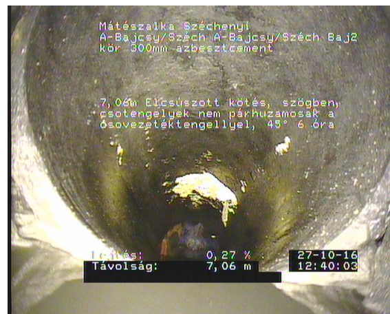
Bajcsy2_74cf3f14-e366-4632-ac17-06c2b6d7bd1d_20161027_124044_030.jpg, 00:01:23, 7.06 Elcsúszott kötés, szögben, a csotengelyek nem párhuzamosak a csövetéktengellyel, 45° 6 óra
