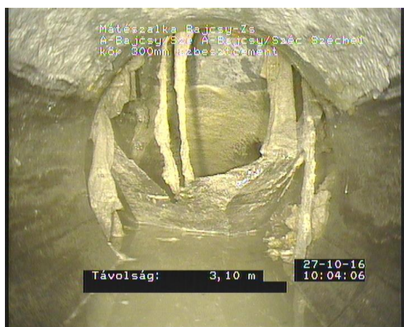
Széchenyi1_d44e8517-fae9-4433-b46c-923a63b12cfe_20161027_100447_437.jpg, 00:01:31, 3.10 Látható talaj. 3 óra -tól(tol) 9 óra, Csocsatlakozásnál
