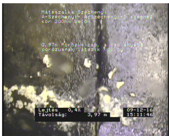
széchenyi2_aaf47d91-fae4-4e9a-8802-79fb2d34895e_20161209_151216_385.jpg, 00:01:02, 3.97 Porózus cso, a cso anyaga porózusnak látszik (pl.gyártási hiba miatt) 12 óra -tól(tol) 11 óra, Csocsatlakozásnál
