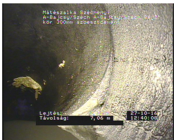
Bajcsy2_74cf3f14-e366-4632-ac17-06c2b6d7bd1d_20161027_124048_764.jpg, 00:01:23, 7.06 Elcsúszott kötés, szögben, a csotengelyek nem párhuzamosak a csövetéktengellyel, 45° 6 óra
