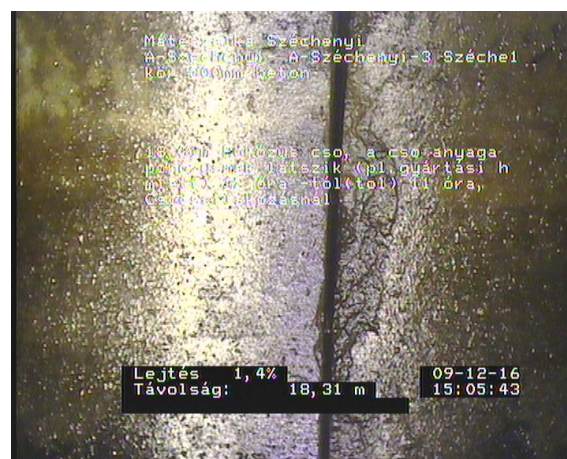
Széchenyi1_734e710d-dc84-4425-9882-9b6b40ed035a_20161209_150613_365.jpg, 00:03:14, 18.31 Porózus csó, a csó anyaga porózusnak látszik (pl.gyártási hiba miatt) 12 óra -tól(tol) 11 óra, Csocsatlakozásnál
