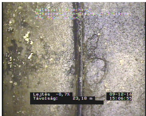
Széchenyi1_734e710d-dc84-4425-9882-9b6b40ed035a_20161209_150724_819.jpg, 00:04:01, 23.18 Porózus csó, a csó anyaga porózusnak látszik (pl.gyártási hiba miatt) 12 óra -tól(tol) 11 óra, Csocsatlakozásnál
