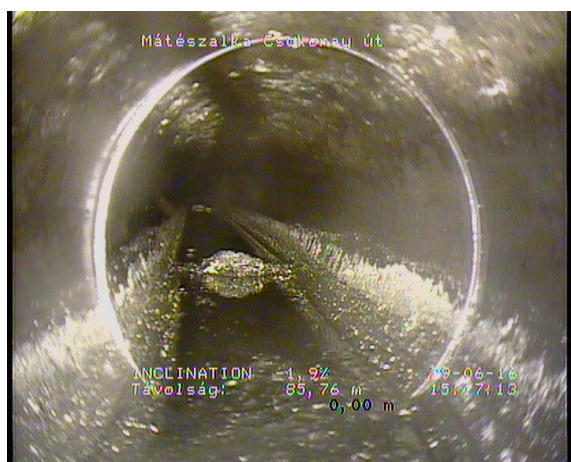
Csokonay-Mátyás k_edfb757d-0d9e-4dbc-893a-9a296f42fe8a_20160629_1518 35_312.jpg, 00:22:13, 85.76 A vezeték görbülete balra, 10° irányváltás
