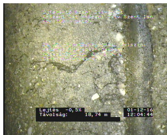
Szent István 3_5dcd8190-2666-4c7c-bdac-b9c962a291b3_20161201_120 505_146.jpg, 00:08:23, 18.74 Repedésképződés, felszíni repedés (hajszálrepedés), hosszirányban, 2mm 2 óra, Csatlakozásnál
