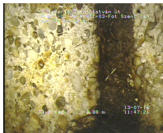
Szent István02_cc86c8ca-bf40-4dab-9cea-2b3e933db063_20160713_114907_693.jpg, 00:01:12, 2.88 Gyökerek, egyedi finom gyökerek, 1% Smárolás 12 óra-tól(tol) 2 óra, Csocsatlakozásnál
