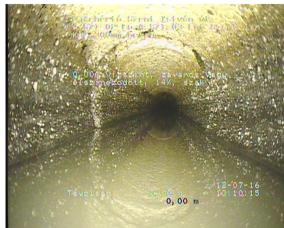
Szent István02_dc1f958b-cf04-4068-83d1-38cda09a1dc7_20160712_131153_920.jpg, 00:00:15, 0.00 Vízszint, zavaros vagy elszíneződött, 14%, szakaszhiba kezdete #
