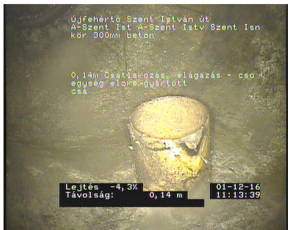
Szent István 2_ee49b850-6c33-4588-9ee1-2d4a2db9cab1_20161201_111400_069.jpg, 00:00:17, 0.14 Csatlakozás, elágazás - cso egység előre gyártott csatlakozóelemmel, csatlakozás nyitva, 160mm 8 óra
