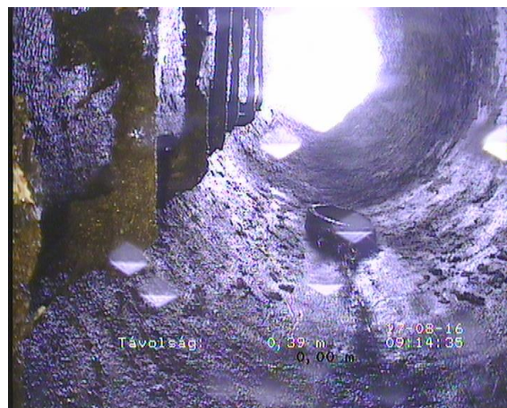
Fotér04_1dc7addb-0c71-4b4a-959c-a3a7650470f9_20160817_091702_509.jpg, 00:00:58, 0.39 Csatlakozás, elágazás - cso egység előre gyártott csatlakozóelemmel, csatlakozás nyitva, 160mm 11 óra
