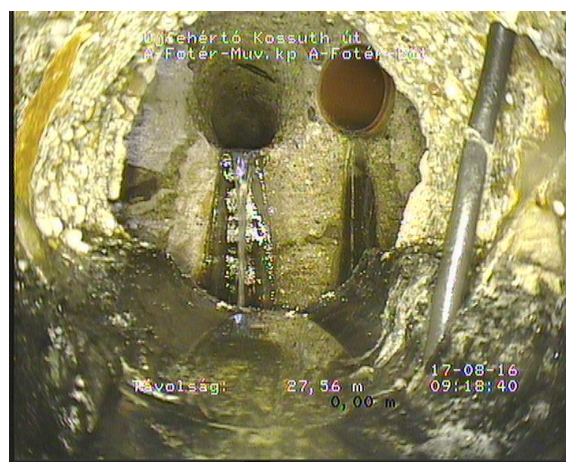
Fotér04_1dc7addb-0c71-4b4a-959c-a3a7650470f9_20160817_092107_688.jpg, 00:04:27, 27.56 Behatóló tömítőanyag, tömítogyuru lelóg, de nem törött, a legmélyebb pontja a vízszintes középvonal alatt v..
