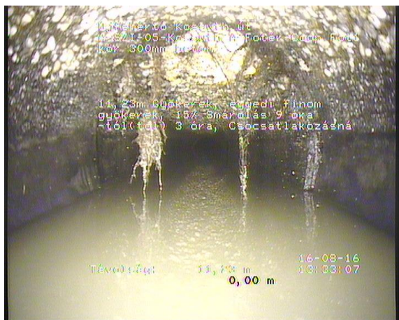
Fotér01_c96e7a06-4674-4ad5-86e4-a75db86e7a4a_20160816_133532_879.jpg, 00:07:36, 11.23 Gyökerek, egyedi finom gyökerek, 15% Smárolás 9 óra -tól(tol) 3 óra, Csocsatlakozásnál
