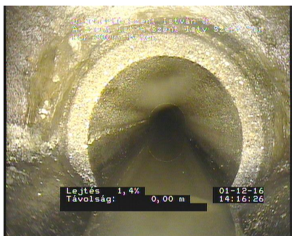
Szent István 7_375e6634-8af5-44e2-bbdd-6bc0526de5fc_20161201_141647_234.jpg, 00:00:23, 0.00 Csatlakozás, elágazás - cso egység előre gyártott csatlakozóelemmel, csatlakozás nyitva, 160mm 8 óra
