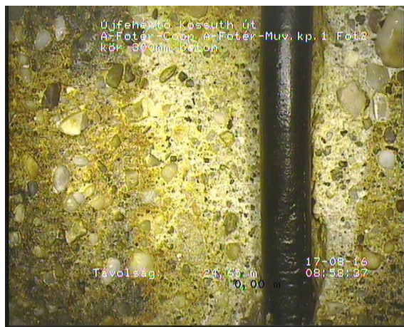
Fotér02_ff43140c-5fc3-4c0a-8720-3d8cb132fc46_20160817_090104_153.jpg, 00:11:53, 24.65 Behatóló tömítőanyag, tömítőgyuru lelóg, de nem törött, a legmélyebb pontja a vízszintes középvonal felett ..
