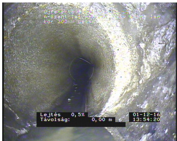
Szent István 5_ea81e9e9-8f05-425f-a0d1-1ed4366914c6_20161201_1354 40_632.jpg, 00:00:37, 0.00 Csatlakozás, elágazás - cso egység előre gyártott csatlakozóelemmel, csatlakozás nyitva, 160mm 4 óra
