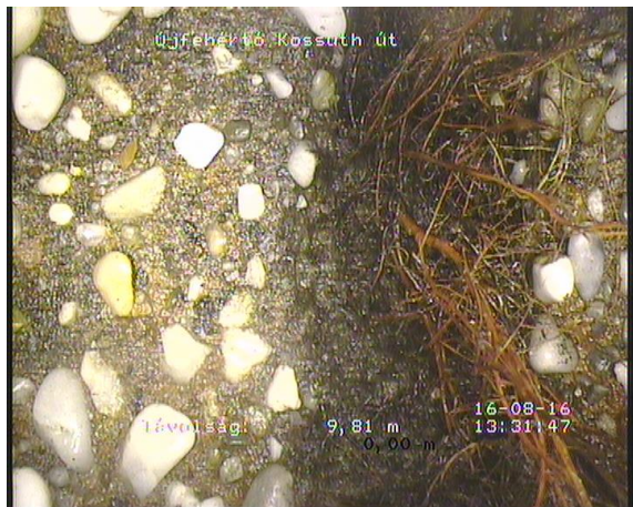
Fotér01_c96e7a06-4674-4ad5-86e4-a75db86e7a4a_20160816_133412_975.jpg, 00:06:38, 9.81 Gyökerek, egyedi finom gyökerek, 5% Smárolás 8 óra -tól(tol) 4 óra, Csocsatlakozásnál
