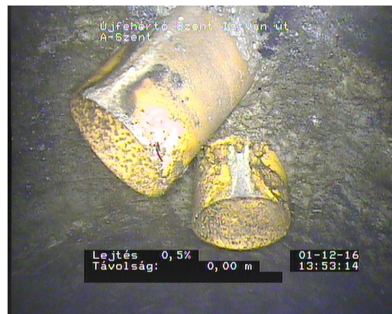
Szent István 5_ea81e9e9-8f05-425f-a0d1-1ed4366914c6_20161201_1353 34_559.jpg, 00:00:16, 0.00 Csatlakozás, elágazás - cso egység előre gyártott csatlakozóelemmel, csatlakozás nyitva, 160mm 9 óra
