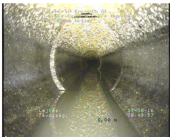
Fotér02_ff43140c-5fc3-4c0a-8720-3d8cb132fc46_20160817_085223_850.jpg, 00:04:01, 10.30 Behatoló tömítőanyag, tömítógyuru lelóg, de nem törött, a legmélyebb pontja a vízszintes középvonal felett ..
