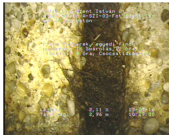
Szent István02_d11da136-1c22-4eb9-b150-39b33fa9dff7_20160713_103111_059.jpg, 00:01:36, 2.96 Gyökerek, egyedi finom gyökerek, 1% Smárolás 12 óra -tól(tol) 2 óra, Csocsatlakozásnál
