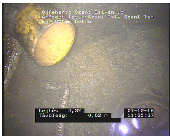
Szent István 3_5dcd8190-2666-4c7c-bdac-b9c962a291b3_20161201_115 557_544.jpg, 00:00:28, 0.01 Csatlakozás, elágazás - cso egység előre gyártott csatlakozóelemmel, csatlakozás nyitva, 160mm 7 óra
