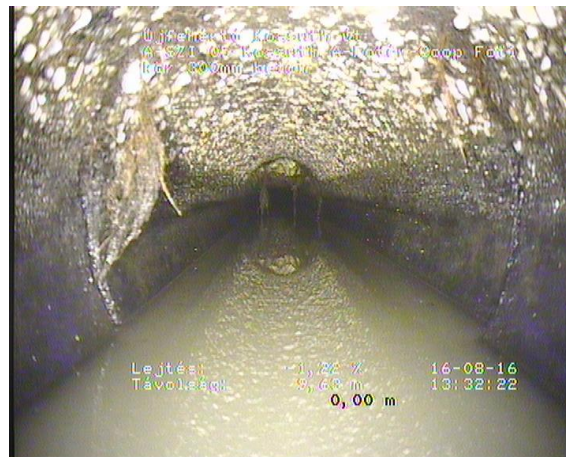
Fotér01_c96e7a06-4674-4ad5-86e4-a75db86e7a4a_20160816_133447_753.jpg, 00:06:38, 9.81 Gyökerek, egyedi finom gyökerek, 5% Smárolás 8 óra -tól(tol) 4 óra, Csocsatlakozásnál
