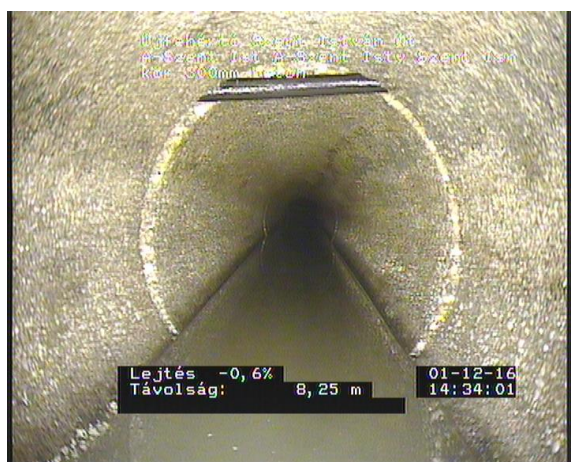
Szent István 8_93c01404-3bf8-423e-bea4-1a46fac7cb7c_20161201_143421_871.jpg, 00:03:59, 8.25 Behatoló tömítőanyag, tömítőgyűrű leelőg, de nem törött, a legmélyebb pontja a vízszintes középvonal felett ..
