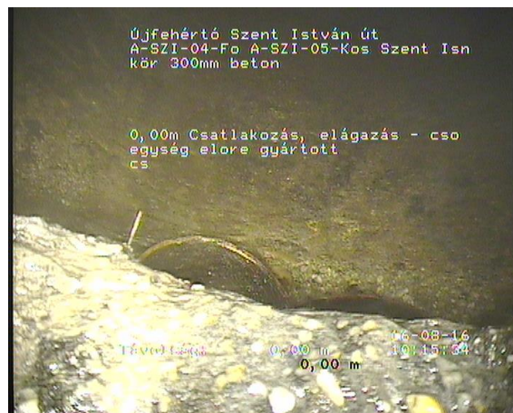
Szent István 04_afe809ca-fafb-449b-9b3b-bef0b7e2b81b_20160816_101759_414.jpg, 00:00:43, 0.00 Csatlakozás, elágazás - cso egység előre gyártott csatlakozóelemmel, csatlakozás nyitva, 160mm 10 óra
