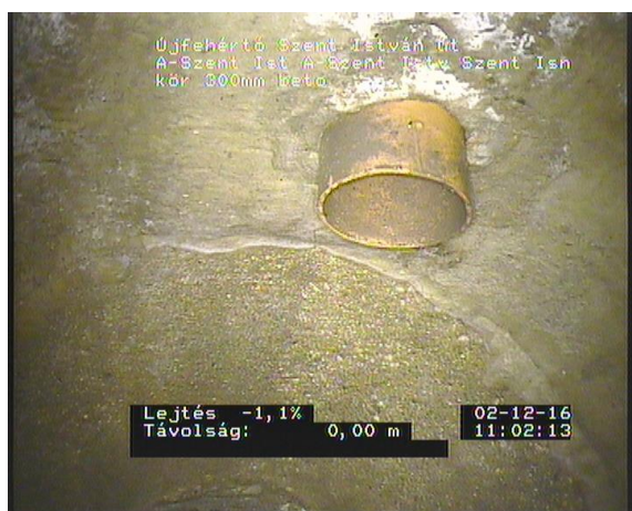
Szent István 11_2246a092-eacb-4235-8bcf-874f39644480_20161202_110 234_855.jpg, 00:00:24, 0.00 Csatlakozás, elágazás - cso egység előre gyártott csatlakozóelemmel, csatlakozás nyitva, 160mm 3 óra
