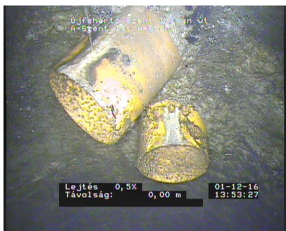
Szent István 5_ea81e9e9-8f05-425f-a0d1-1ed4366914c6_20161201_1353 47_995.jpg, 00:00:19, 0.00 Csatlakozás, elágazás - cso egység előre gyártott csatlakozóelemmel, csatlakozás nyitva, 160mm 9 óra
