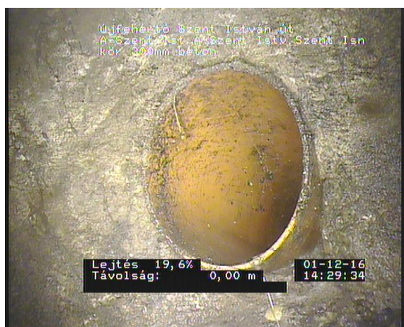
Szent István 8_93c01404-3bf8-423e-bea4-1a46fac7cb7c_20161201_1429 54_728.jpg, 00:00:49, 0.00 Csatlakozás, elágazás - cso egység előre gyártott csatlakozóelemmel, csatlakozás nyitva, 200mm 5 óra
