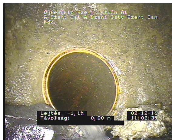
Szent István 11_2246a092-eacb-4235-8bcf-874f39644480_20161202_110 256_399.jpg, 00:00:36, 0.00 Csatlakozás, elágazás - cso egység előre gyártott csatlakozóelemmel, csatlakozás nyitva, 200mm 8 óra
