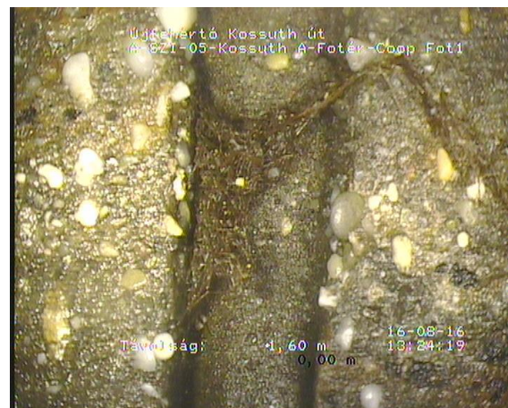
Fotér01_c96e7a06-4674-4ad5-86e4-a75db86e7a4a_20160816_132644_528.jpg, 00:01:01, 1.60 Gyökerek, egyedi finom gyökerek, 3% Smárolás 8 óra -tól(tol) 4 óra, Csocsatlakozásnál
