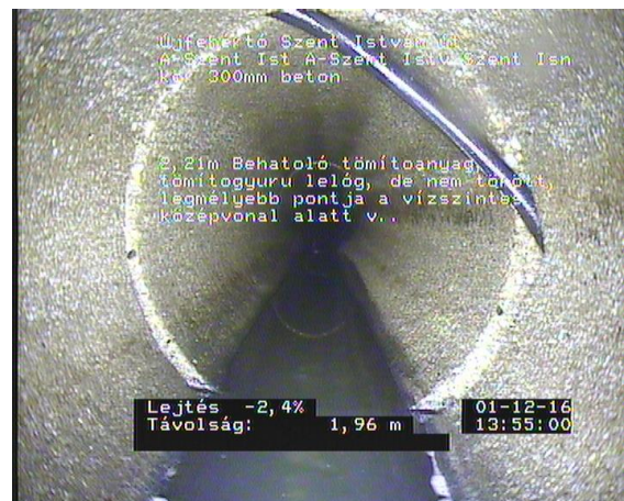
Szent István 5_ea81e9e9-8f05-425f-a0d1-1ed4366914c6_20161201_1355 20_626.jpg, 00:01:14, 2.21 Behatoló tömítőanyag, tömítőgyuru lelóg, de nem törött, a legmélyebb pontja a vízszintes középvonal alatt v..
