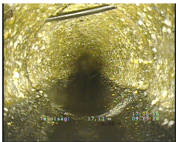
Fotér04_1dc7addb-0c71-4b4a-959c-a3a7650470f9_20160817_091947_749.jpg, 00:03:27, 17.13 Behatóló tömítőanyag, tömítogyuru lelóg, de nem törött, a legmélyebb pontja a vízszintes középvonal felett ..
