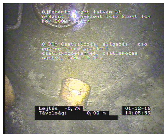
Szent István 6_b8437dc2-d2d9-44a8-971e-0a7a34eb2b21_20161201_140 619_500.jpg, 00:00:25, 0.00 Csatlakozás, elágazás - cso egység előre gyártott csatlakozóelemmel, csatlakozás nyitva, 160mm 9 óra
