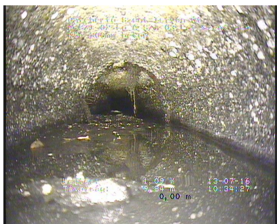
Szent István02_d11da136-1c22-4eb9-b150-39b33fa9dff7_20160713_103607_481.jpg, 00:06:04, 9.84 Kirakódott anyagok, lerakódás, 15% Smárolás 4 óra -tól(tol) 8 óra, szakaszhiba kezdete #
