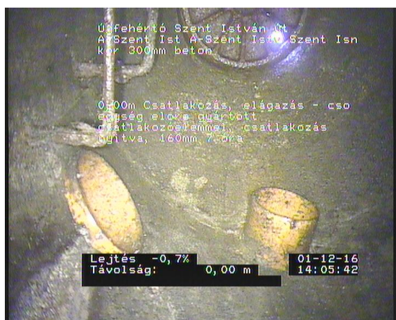
Szent István 6_b8437dc2-d2d9-44a8-971e-0a7a34eb2b21_20161201_140 603_305.jpg, 00:00:20, 0.00 Csatlakozás, elágazás - cso egység előre gyártott csatlakozóelemmel, csatlakozás nyitva, 160mm 7 óra
