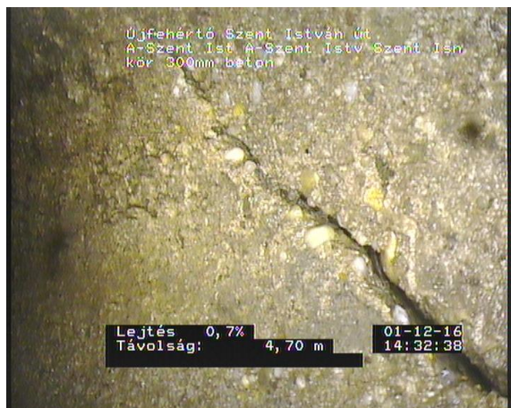
Szent István 8_93c01404-3bf8-423e-bea4-1a46fac7cb7c_20161201_143259_354.jpg, 00:03:03, 4.70 Repedésképződés, a törésvonalak felismerhetők a csőfalán, hosszirányban, 5mm 10 óra, Csocsatlakozásnál
