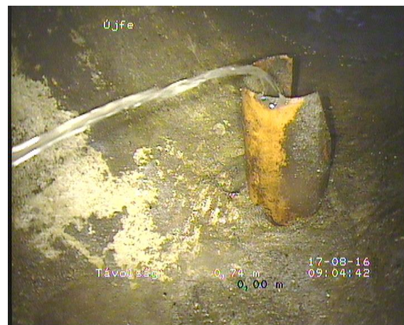
Fotér03_f9788255-1959-4698-9407-9e1ea5edc7fd_20160817_090708_964.jpg, 00:00:18, 0.74 Csatlakozás, elágazás - cso egység előre gyártott csatlakozóelemmel, csatlakozás nyitva, 160mm 1 óra
