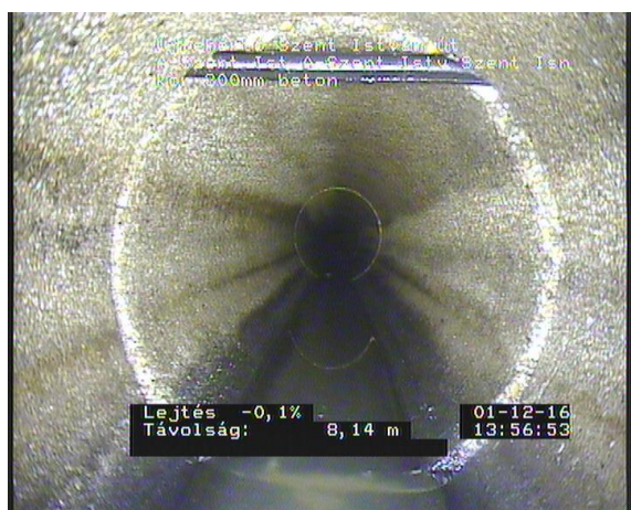
Szent István 5_ea81e9e9-8f05-425f-a0d1-1ed4366914c6_20161201_1357 13_506.jpg, 00:02:38, 8.16 Behatoló tömítőanyag, tömítőgyuru lelóg, de nem törött, a legmélyebb pontja a vízszintes középvonal felett ..
